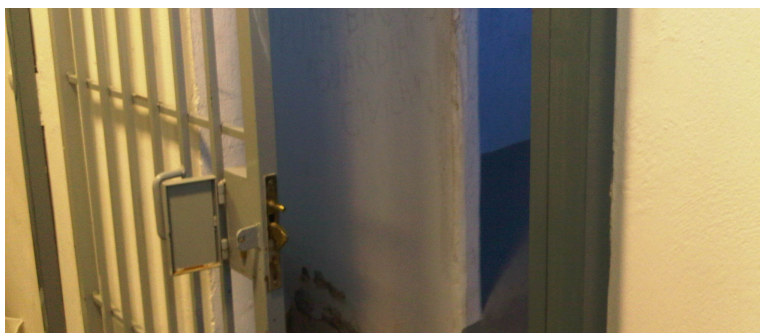
* Detalle celdas del Depósito municipal de detenidos.
